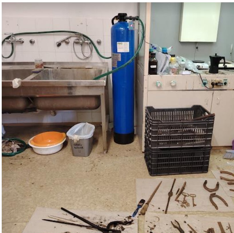
HF-250-1054-MX kevertágyas ioncserélő az újonnan kialakított fémműhelyben
