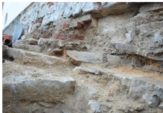
10. A tótvázsonyi református templom alapozásánál látható vakolatmaradvány
