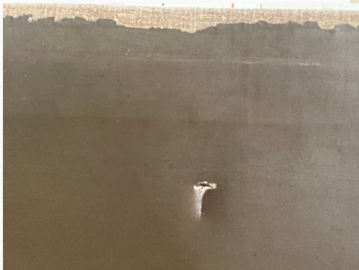
A festett rétegen történt sérülések, hiányok, szakadások
