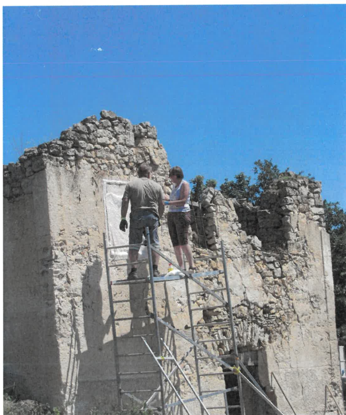
13. kép: A fotón látható vakolatkeretet restaurátoraink konzerválás céljából leválasztották a falról, mely reményeink szerint a tervezett dörgicsei helytörténeti gyűjteményben kap majd elhelyezést. Törő Bence felvétele.
